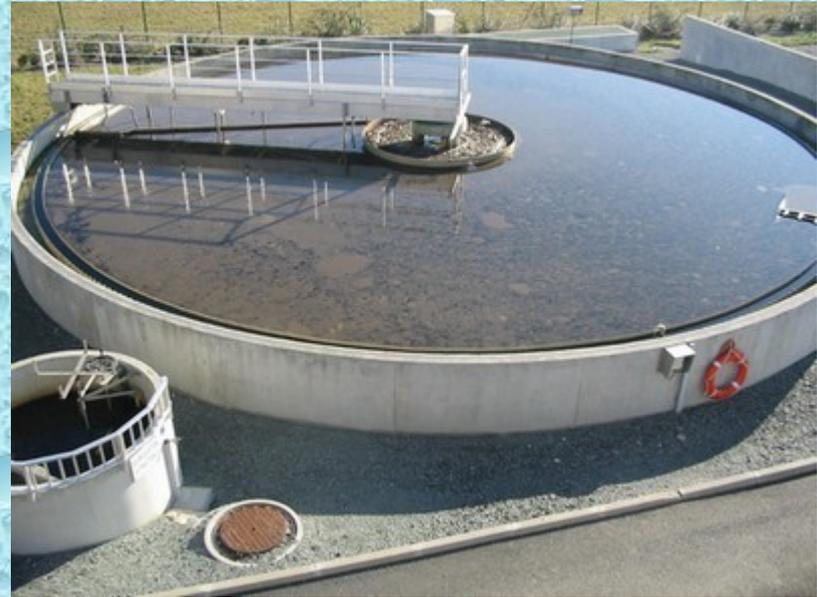
**La décantation** (solide / liquide) et (liquide / liquide) : On sépare des espèces chimiques liquides non miscibles, de densités différentes.
